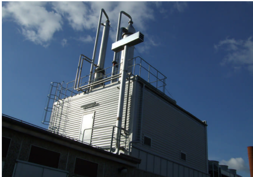
Fig. 4. Göteborg Energi AB:s uppgraderingsanläggning i Arendal i Göteborg, levererad av Läckeby Water Group. Teknologin som används för uppgraderingen är kemisk absorption och anläggningen har en kapacitet på att uppgradera 1600 Nm 3 rågas per timme. Den uppgraderade gasen injiceras på gasnätet.
