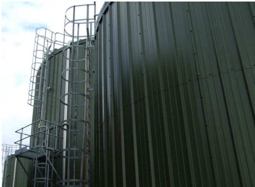
Fig. 1. Greenfinish biogasanläggning i Ludlow, Storbritannien, där källsorterat hushållsavfall rötas. Den producerade biogasen används för elproduktion.
