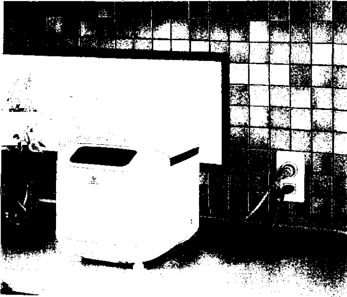
Bild 6 Kombinerat el - gasvägguttag med ansluten riskokare
