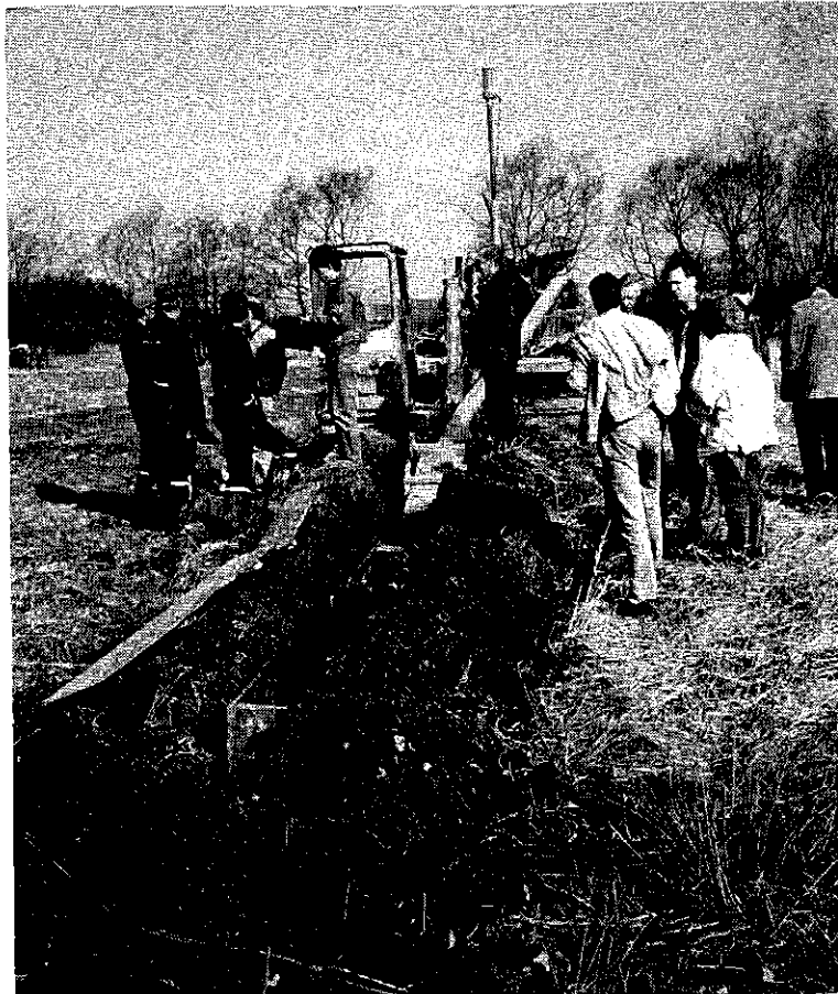
Fig 3. Läggboxens topptätning avlägsnades vid en visning av plöjningstekniken. Mitt i bilden, på en stång ca 2 m ovan plöjningsmaskinen, ser man en lasermottagare som möjliggör läggning med förutbestämd lutning eller nivå.
